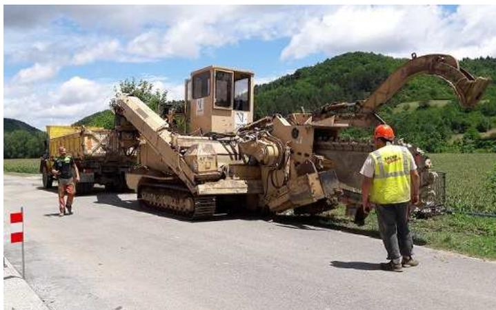
Les travaux ont débuté fin mai 2017 sur la partie nord du village par la construction de la cellule du réducteur de pression située à Noël et par la pose de la nouvelle conduite d'eau en tranchée en bordure et traversées de la
